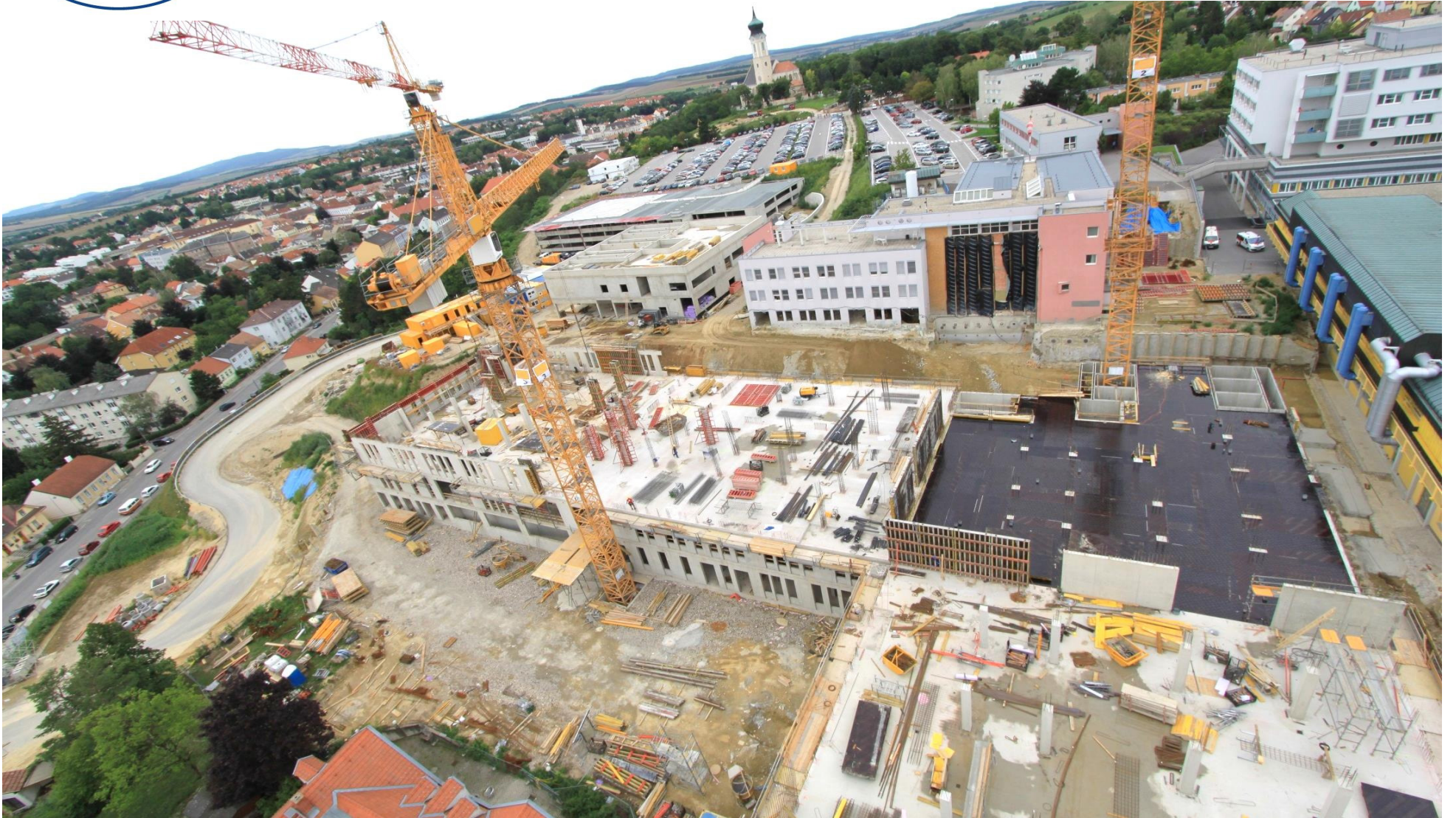
Baustelle Landeskrankenhaus Mistelbach – Neubau – Arch. Moser-Maurer, Baukosten € 175 Mio. 2012 - 2014
